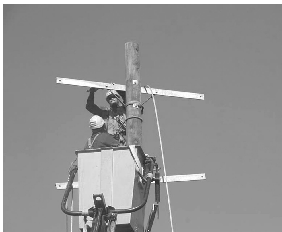
Les électriciens cubains travaillent sur une ligne de transport primaire qui reliera la capitale à la centrale hydroélectrique de Trafalgar, située à huit kilomètres.
